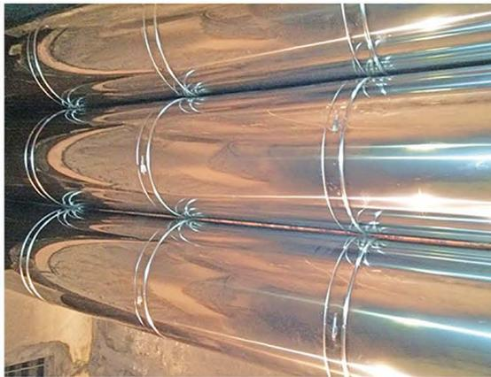
Todos ellos están conectados e silenciadores para evitar la transmisión del ruido de los extractores al exterior del edificio. Y van hasta el tejado del edificio (a 24m del nivel del suelo) instalados dentro de una estructura de acero especialmente diseñada por JEREMIAS.
