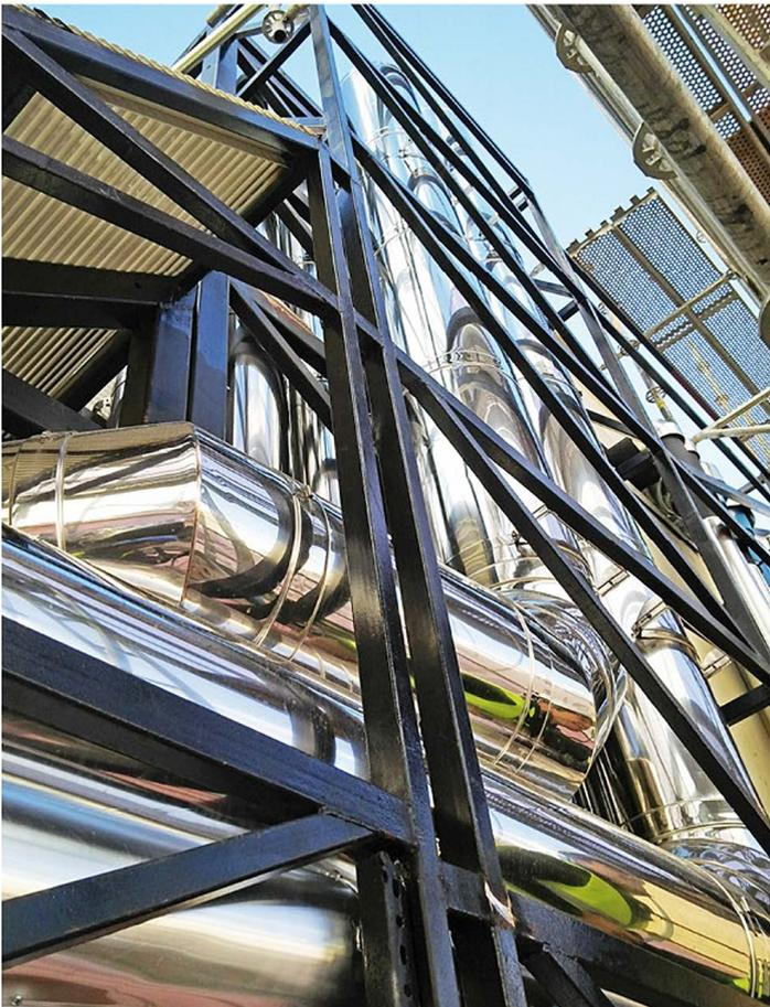
Para este proyecto JEREMIAS ha producido e instalado toda la red de conductos de extracción de las cocinas de los locales. Estos conductos se han diseñado con el sistema SV-EI30, un sistema de doble pared con aislamiento testado para obtener la clasificación EI30 según la norma UNE-EN 13501-3 para conductos de ventilación.
