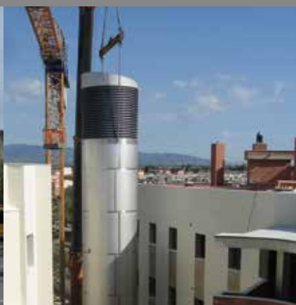
FSC, Ø 2.760 mm, 18 m de altura.
